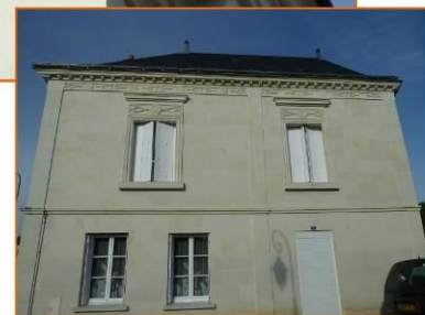
Maison du lavoir rue du Pont Mineau
